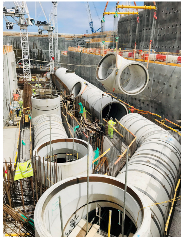
Het begon met ongeloof bij de opdrachtgever, maar Denys werd verkozen tot 'best international contractor' voor de bouw van de gigantische koelleidingen voor de kerncentrale Hinkley Point C in Somerset.
